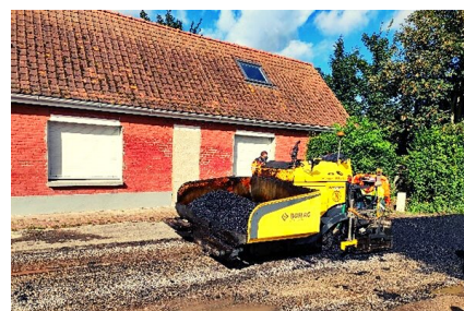
Mise en place enrobé rue de la Rivière
