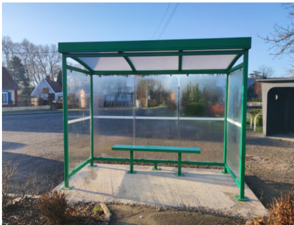
Pose d'un nouvel abribus Place du Pont
